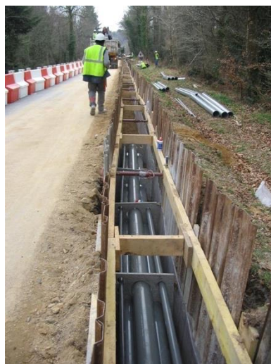
Coupe type d'une liaison souterraine en technique 63 000 volts (pose en trèfle)
