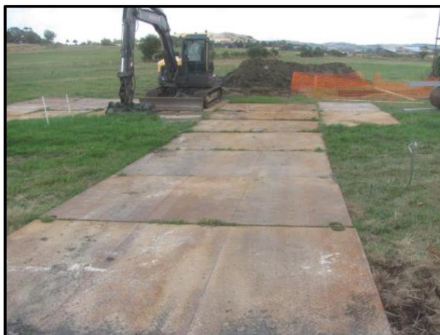
Accès et plateforme des travaux sur plaques métalliques pour travaux en zone humide (mesure R4) J. SCHLEICHER, 29/08/2023, Andelat (15)
