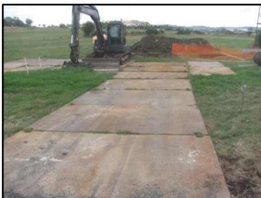
Illustration d'un accès et plateforme sur plaques.
